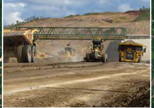
Jembatan Indra, lokasi dimana ban berjalan berada di atas area jalan tambang.
