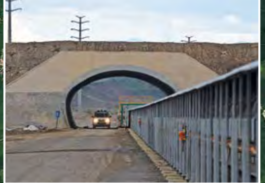
Jembatan Sapta, lokasi dimana ban berjalan berada di bawah area jalan tambang.
