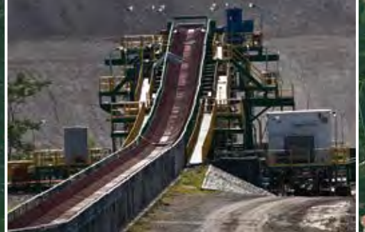
Pada bagian akhir konveyor yang statis, lapisan penutup dipindahkan ke "crawling" spreader arm yang dikendalikan dengan komputer.
